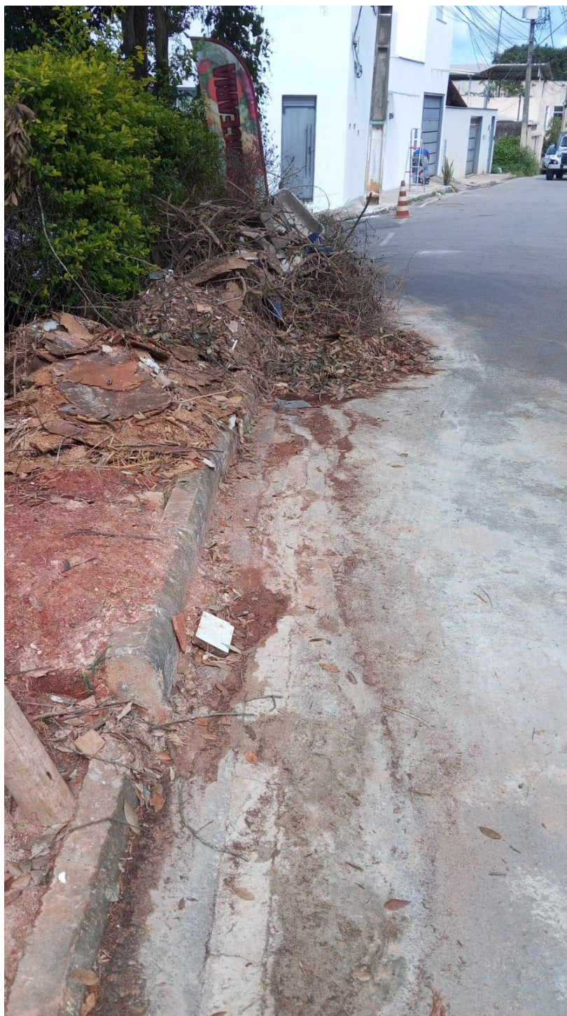
Rua Belo Vale esquina com Rua Ouro Preto Bairro Dona Luízinha
