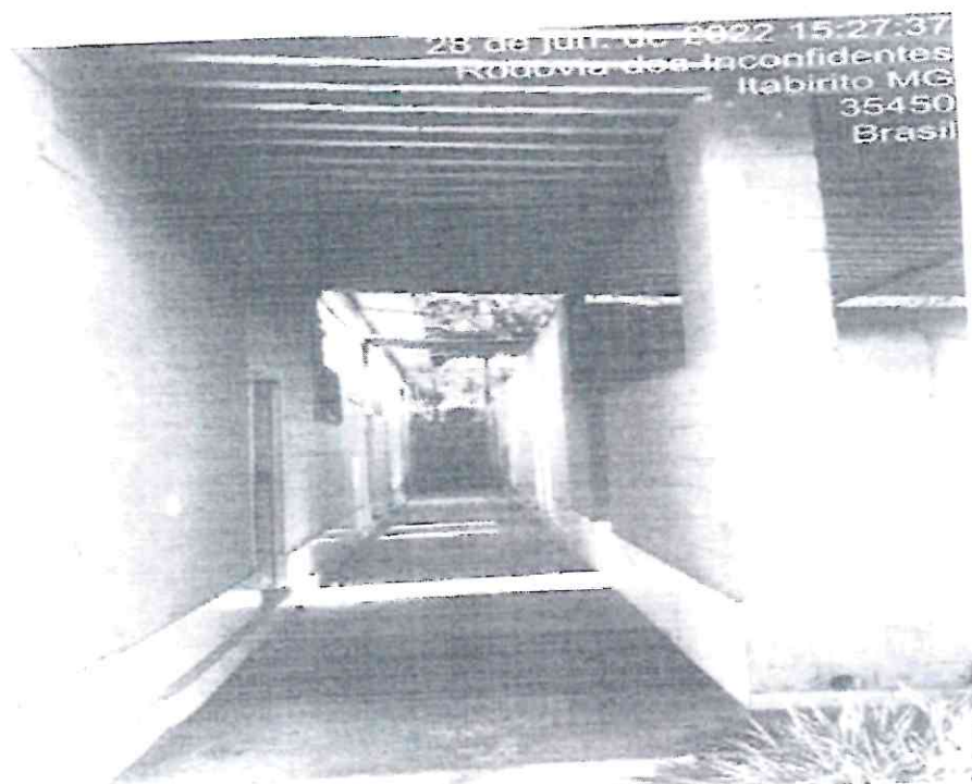
Imagem 13: Corredor de ligação do imóvel
