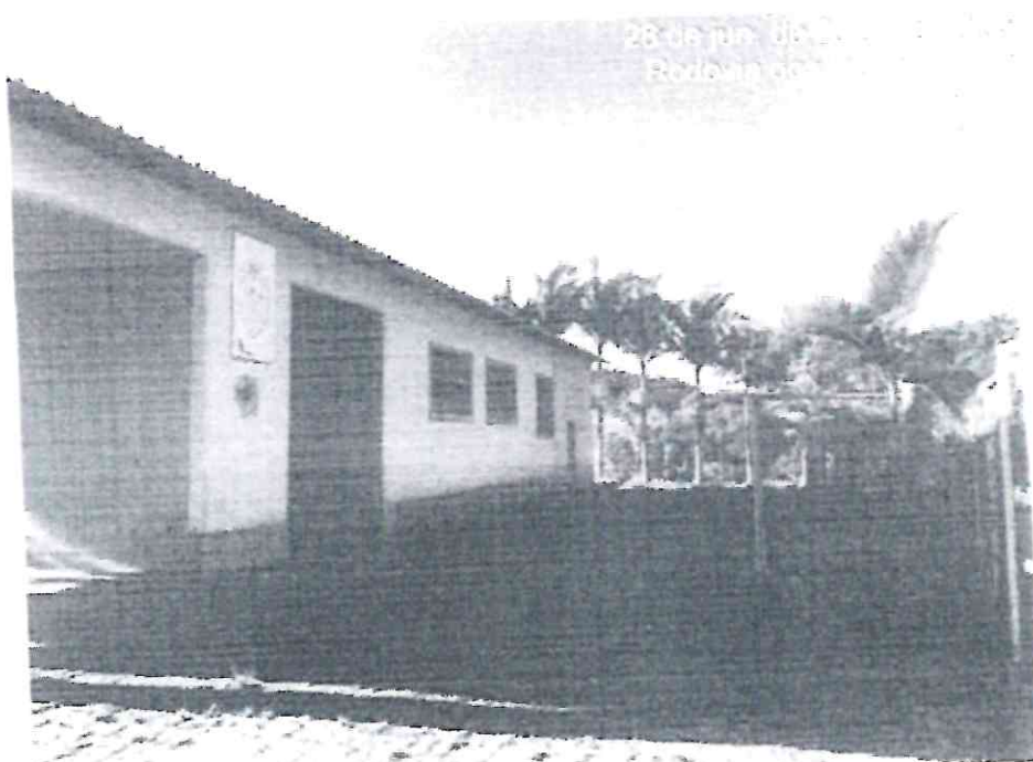
Imagem 4: Foto da fachada do imóvel
